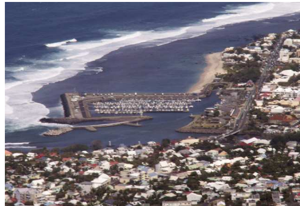
Image 21: Vue aérienne du Port de Saint Pierre après sa rénovation
