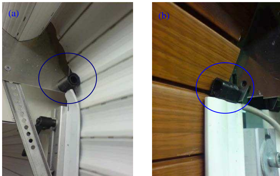
Figure II-8 : Guidage du volet au moyen (a) d'une roulette de guidage, ou (b) d'une tulipe
