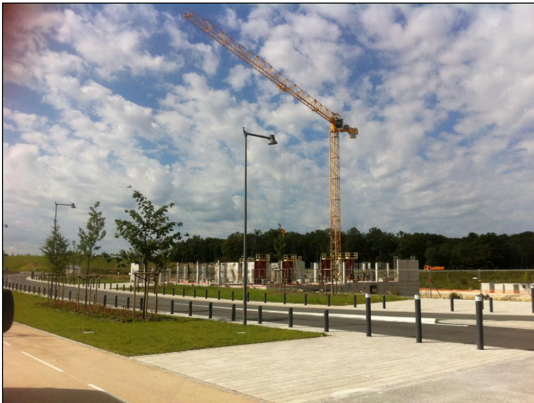
Figure 3 - 39 Le début des travaux de la ZAC la « JonXion » (10/07/2012)
