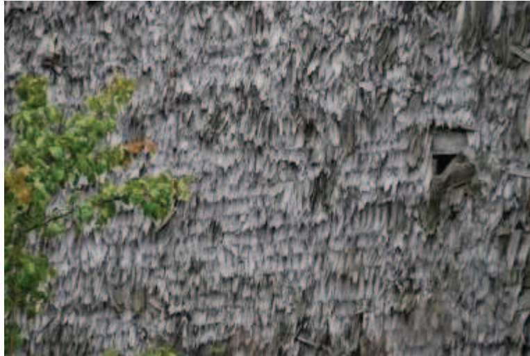
Photo 154: Mur recouvert de tavailon ou ancelles (Boujeons, Doubs)
