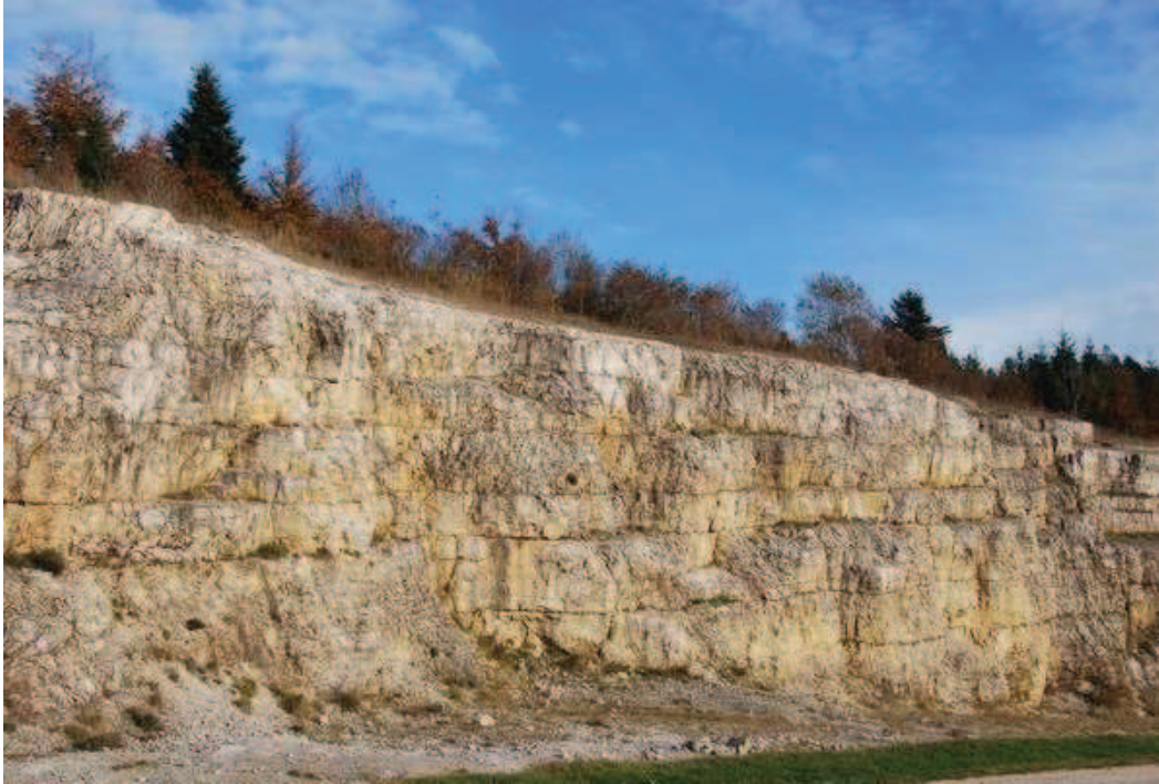
Photo 19: Déviation des Hôpitaux-Métabief (Doubs N.57). Terrains du Jurassique supérieur (faciès Portlandien) constitués de gros bancs de calcaire blancs compact résultant d'une succession de phases sédimentaires. Photo B. Renaud
