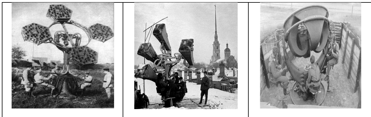
Figure 1.2 - Télésitemètres de Perrin et paraboloïde de Baillaud
