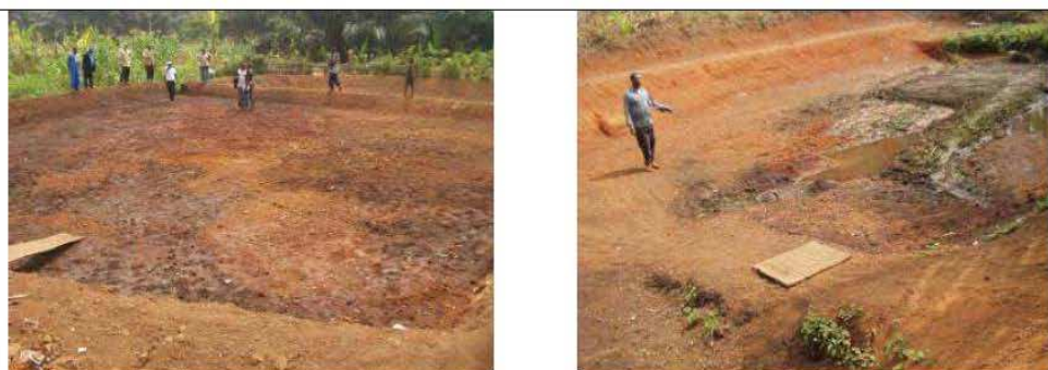
Figure 2 : Etang construit sur un sol grossier et riche en matière organique
