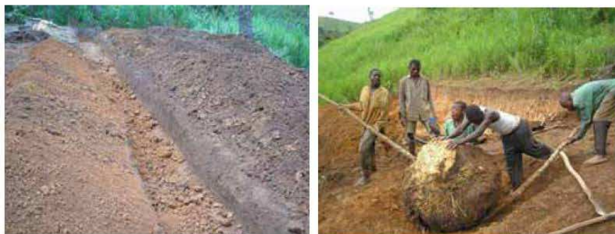
Figure 7 : Elimination des troncs et décapage de la couche organique
