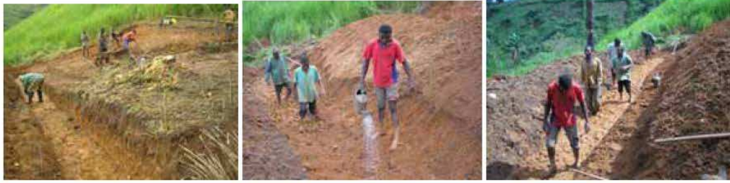
Figure 8 : La tranchée du noyau de la digue
