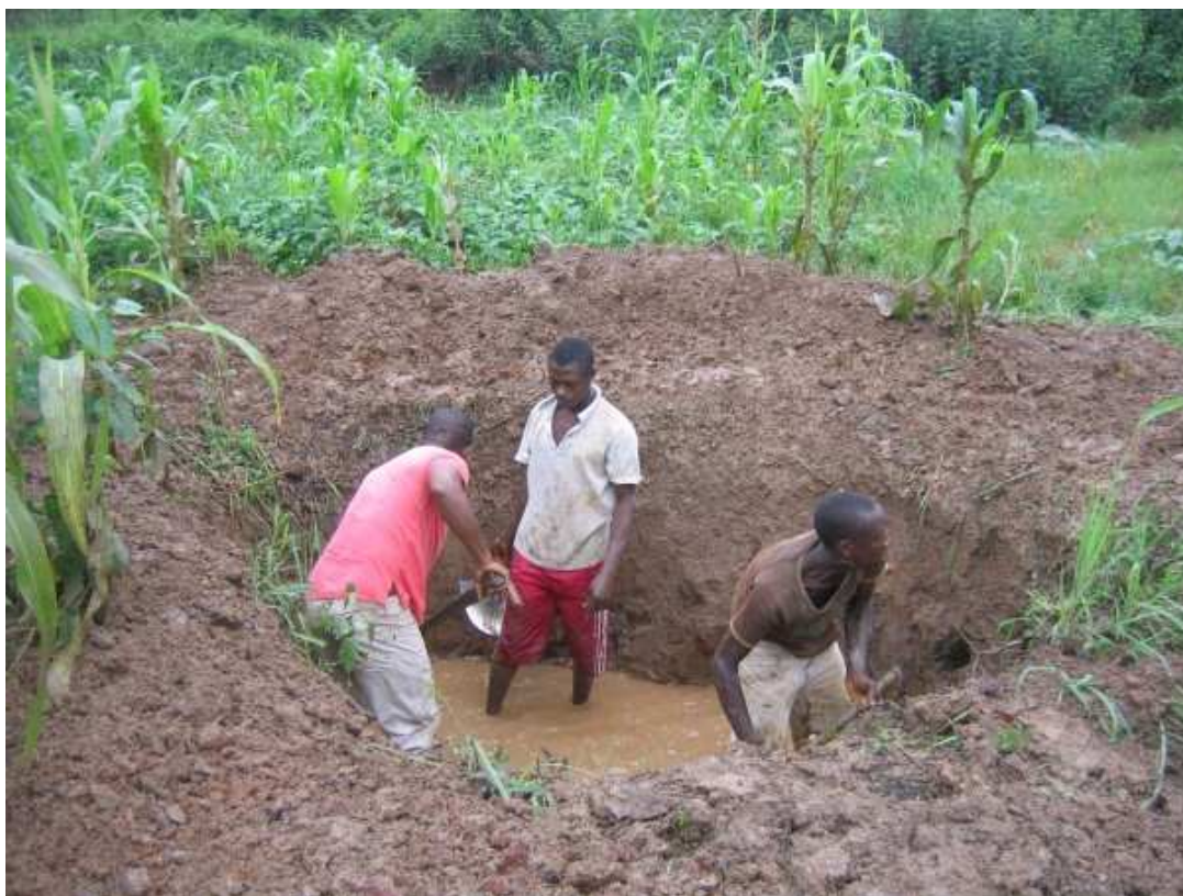
Photographie 7. Construction d'un étang traditionnel à Santchou
