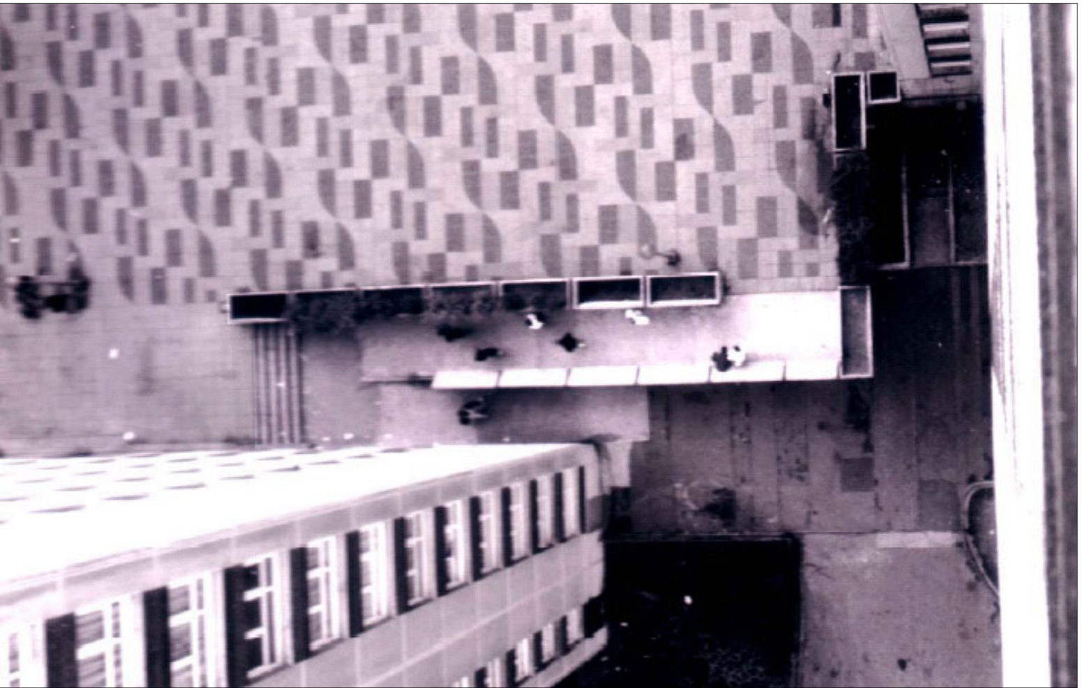
Une chicane permettant de passer du niveau rue à la dalle intermédiaire (Eluard, Bobigny)
