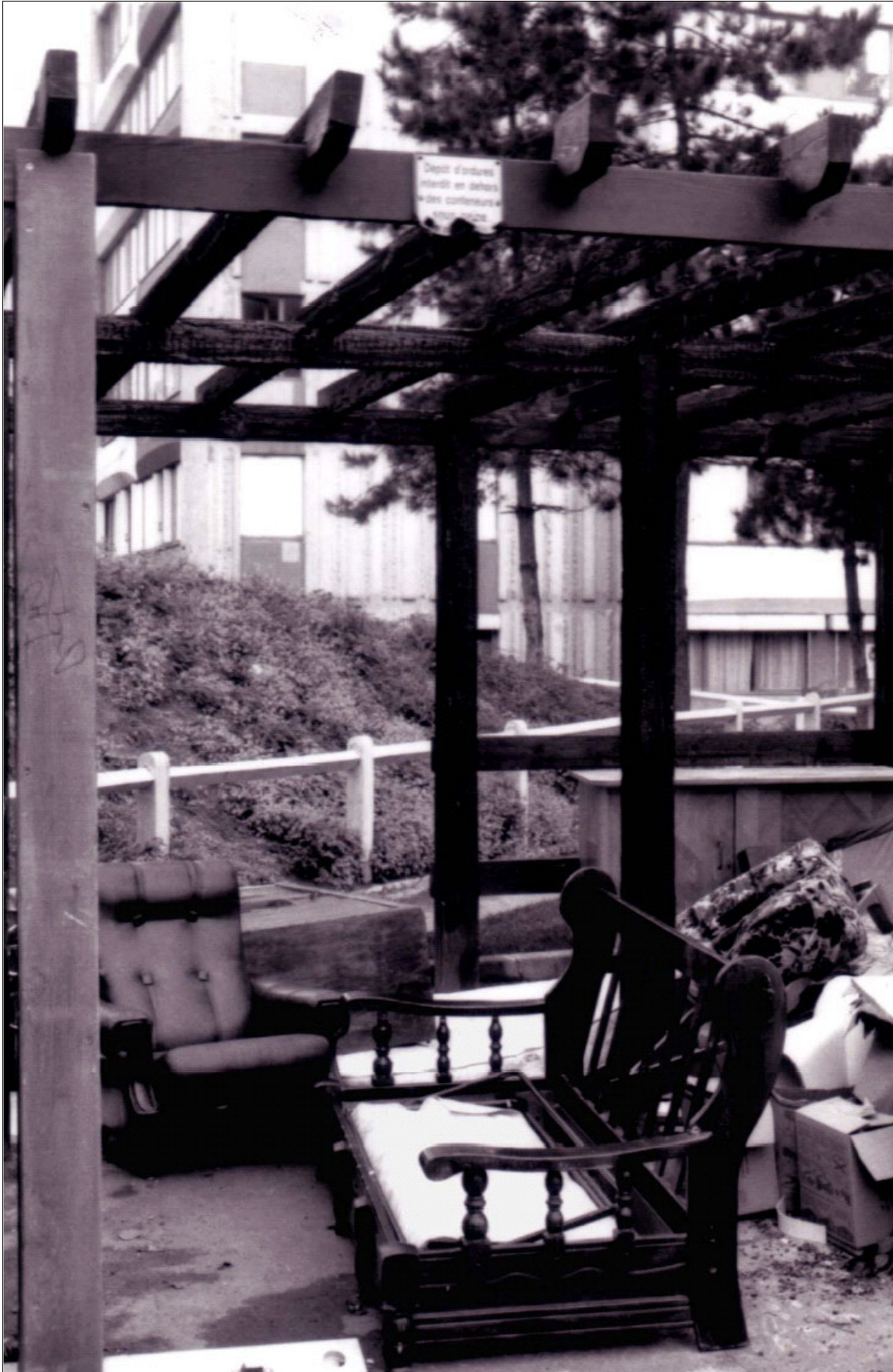
Local à encombrants incendié (Bobigny)
