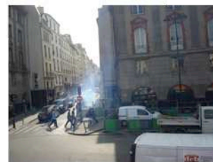
3- Travaux quai de Seine (Rive gauche)
