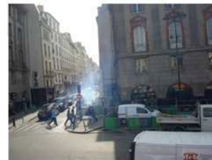
3- Travaux quai de Seine (Rive gauche)
