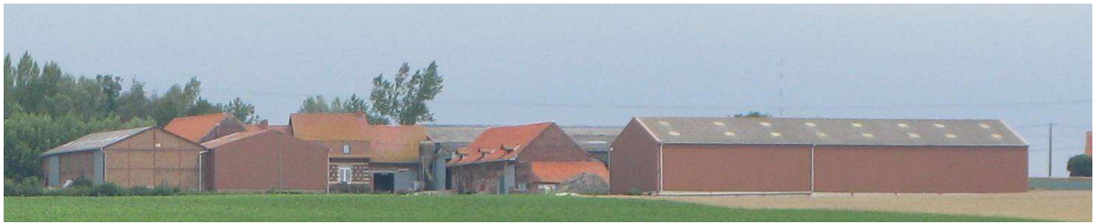
Photo 20. La densification du bâti agricole (Strazeele, 24 juillet 2011)
