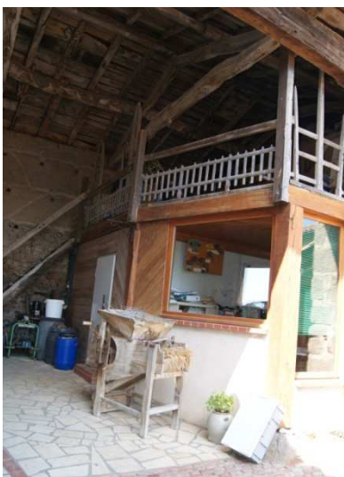
Photo 26. Intérieur du chapitre aménagé en bureau
