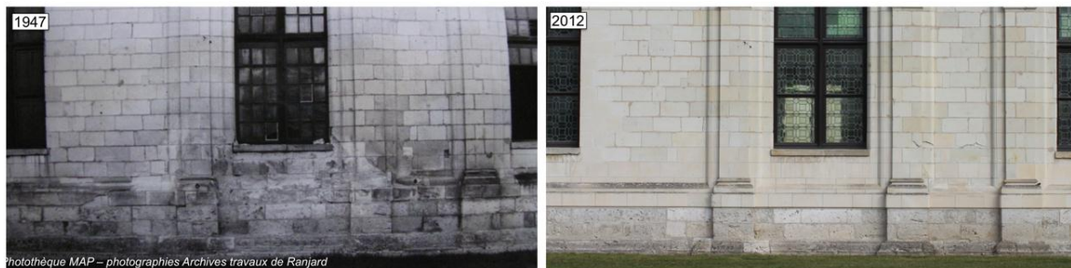
FIGURE 26 : ETAT DE LA BAIE N°16 DE L'AILE SUD AVANT ET APRES LA RESTAURATION DE 1955
