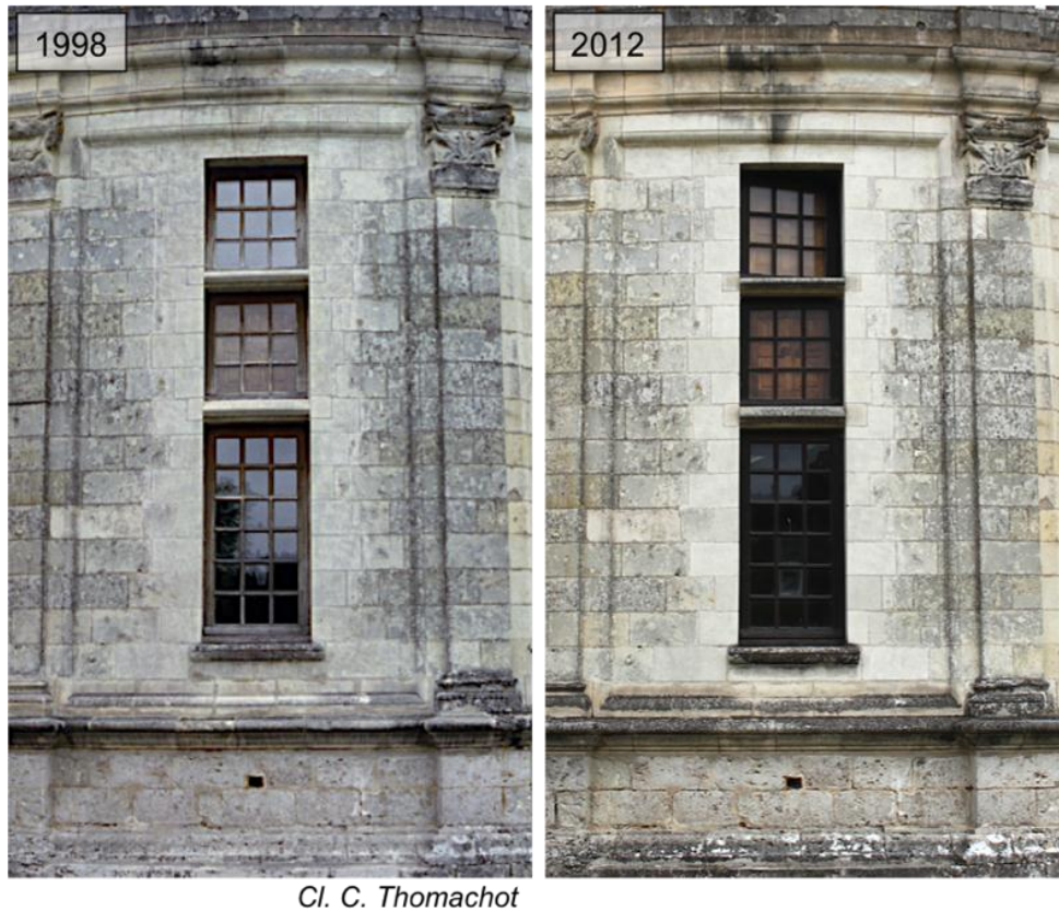
FIGURE 62 : TRAVÉE N°2 DE LA TOUR DU CHAUDRON RESTAURÉE EN 1994. COMPARAISON DES ETATS DE 1998 ET 2012
