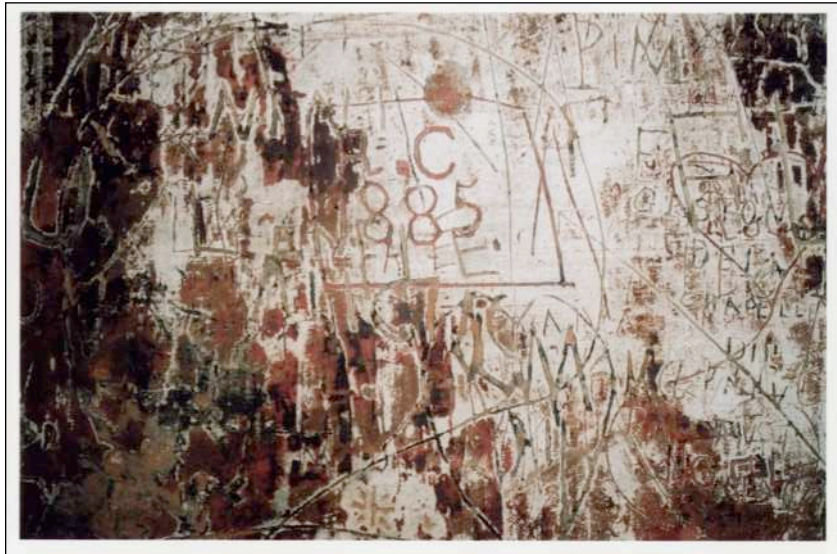
« R.C., 1885 », le plus ancien graffiti daté observable sur le mur du 3 ème balcon du théâtre des Bouffes du Nord.
