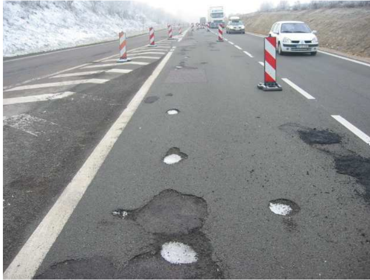
FIGURE 1.11 – Séries de nid de poule dans les bandes de roulement [Mauduit et al., 2007]
