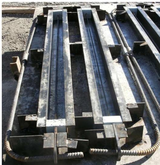
FIGURE 3.13 – Mise en place du coffrage du tirant
