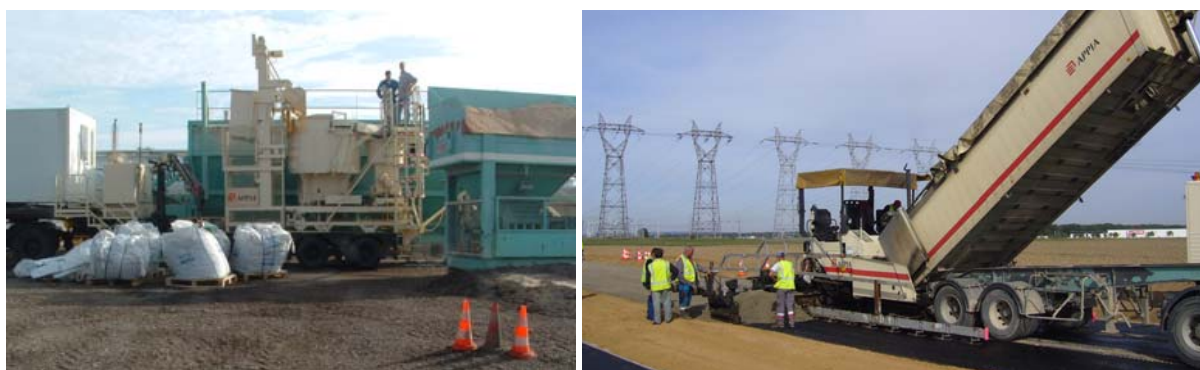
Figure 55. Machine de dosage de fibres installée sur centrale mobile (EIFFAGE Travaux Publics, 2006). Mise en œuvre de FRCC à 40% de fraisats sur le chantier expérimental de la RD 821 (28) faisant l'objet d'un suivi dans le cadre du projet ANR RECYROUTE.
