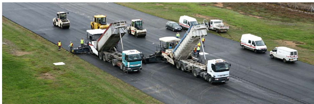
Figure 58. Exemple de chantier LEA® de 3100 tonnes (aérodrome vers Béziers, France).
