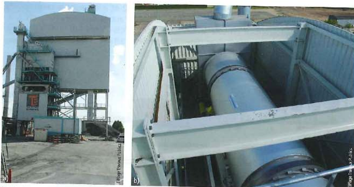
Photos 4 (a) Vue d'ensemble du poste HPR discontinu, bardé, de Touraine Enrobés (Esvres-sur-Indre) (b) Vue du tambour tiédisseur dédié aux agrégats d'enrobés recyclés (a) General view of HPR enclosed batching plant of Touraine Enrobés (Esvres-sur-Indre) (b) View of warming drum dedicated for recycled asphalt aggregate
