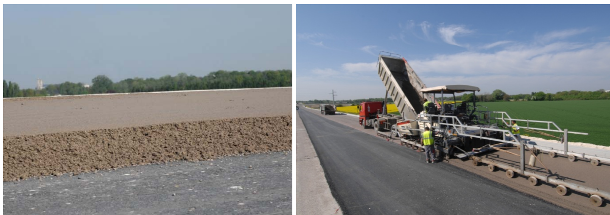
Figure 54. Mise en œuvre de la grave traitée ERTALH sur la déviation sud-est de Troyes (EIFFAGE Travaux Publics, 2008). Fabrication à partir d'une centrale mobile continue.
