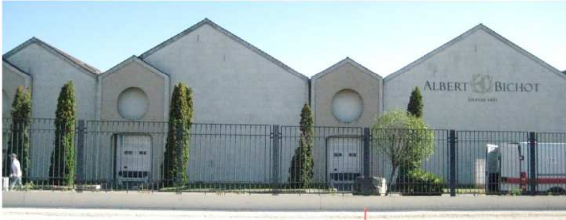
a) Quais de manutention pour les camions chez Albert Bichot, négociant à Beaune
