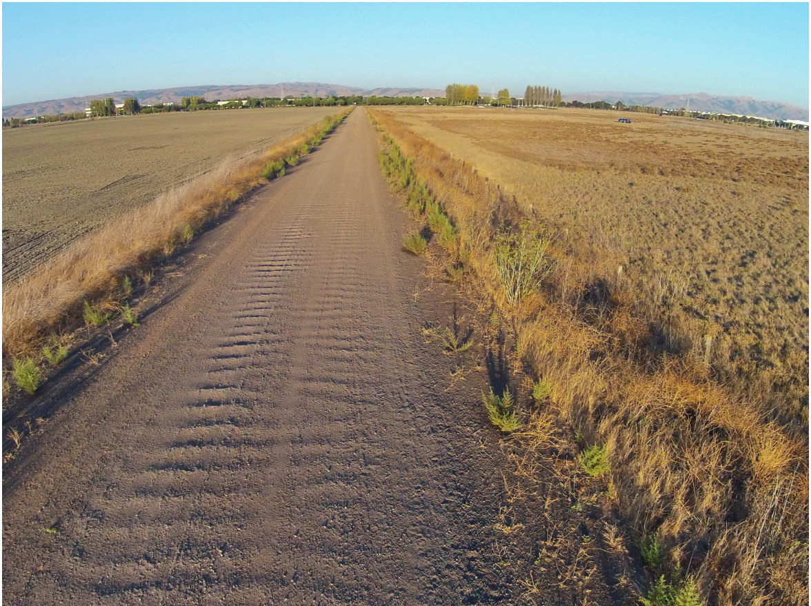
FIGURE 1.1 – Route en tôle ondulée aux abords de Frémont (USA) . On observe un motif régulier de rides transverses à la route et qui s'étend sur toute la longueur de la piste. La distance entre deux rides est de l'ordre de la dizaine de centimètres et leur hauteur de l'ordre du centimètre. On imagine assez facilement que la conduite sur cette route est fort désagréable.
