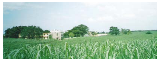
Zone industrielle privée au milieu des champs de canne à Rivière du Rempart, au nord de l'île (dans district rural)
