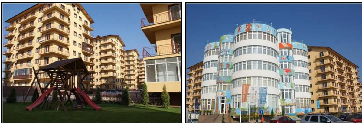
Photo n° 12, Photo n° 13 : Vue sur les immeubles de Militari Residence
