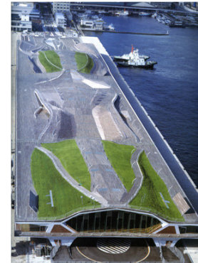
Fig. 9a FOA, Terminal portuaire, Yokohama, Japon (2000)
