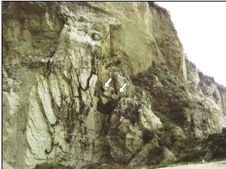
Figure 4.34. Front de la carrière Kanaan. Les flèches indiquent les entrées de Mgharet « 22 April ». Dans la partie gauche de la photo, au niveau de la paroi de couleur plus claire, on remarque la présence d'un conduit karstique sub-vertical entrecoupé par des tronçons courbes. Ces conduits correspondent-ils à des paléo-siphons et rejoignent-ils le creusement vertical de « 22 April » ? (Cliché : B. Jabbour-Gédéon)
