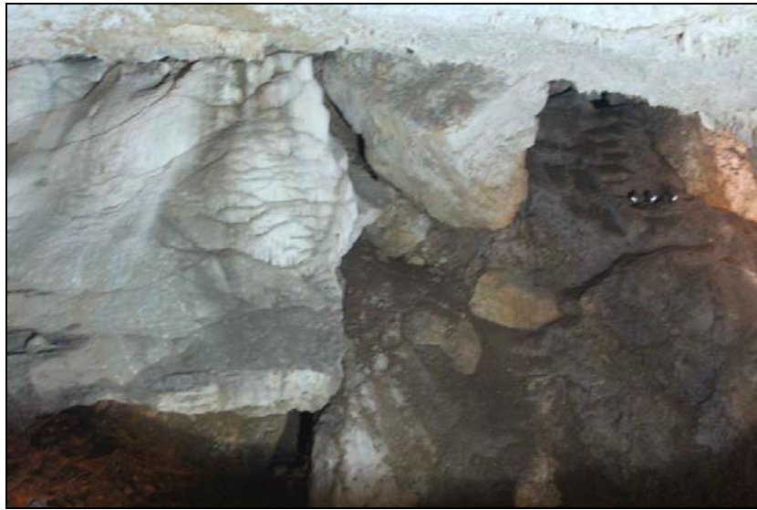
Figure 8.37. A gauche, on observe que le plancher qui recouvre la terrasse fluviale est interrompu, probablement par la chute des blocs provenant de l'effondrement de la voûte (à droite de la photo) (Cliché J. Safi).
