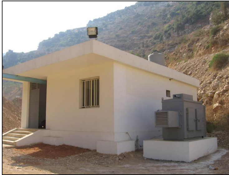
Figure 4.21. La chambre de l'Office des Eaux de Beyrouth et du Mont-Liban est construite sur l'entrée actuelle du réseau d'el Kassarat. Un forage de 4 m de diamètre et de 16 m de profondeur donne accès au toit de la galerie « de la Rivière », à 150 m. du siphon terminal (Cliché C. Nehme).
