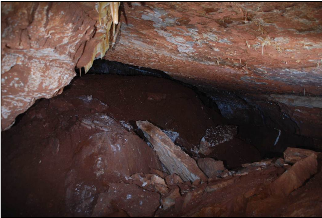
Figure 4.14. La salle « d'Effondrement I » doit sa physionomie actuelle à l'écroulement d'une strate calcaire d'un à deux mètres d'épaisseur. Les blocs au sol correspondent à cette strate écroulée et « moulent » le soutirage qui affecte les argiles paragéométriques. Ce soutirage, le plus important de la cavité, est de l'ordre de 4,25 m de profondeur pour un diamètre de 24 m. Il est intéressant de relever au premier plan, sous le pan écroulé, la morphologie initiale de la cavité qui est révélée ici par le départ du remplissage argileux. Cette paroi présente des vagues d'érosion et des banquettes-limites contemporaines du fonctionnement paragéométrique du drain originel (Cliché B.Sadier).
