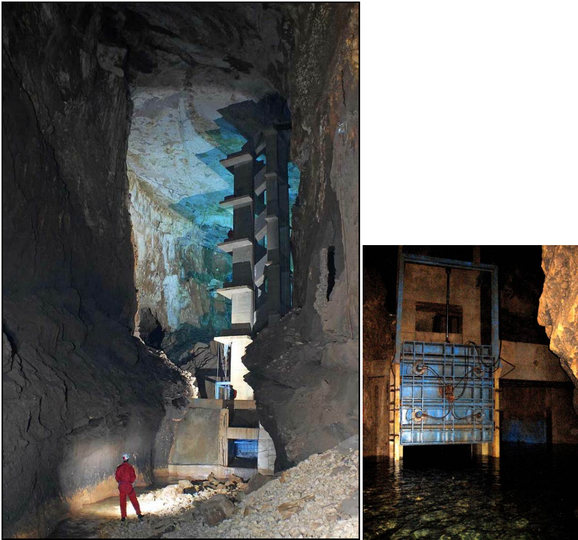
Figure 4.20. La photo de gauche montre la galerie « de la Rivière », prise en aval du barrage construit pour le captage des eaux d'el Kassarat. Nous remarquons à droite les escaliers construits dans le prolongement du forage creusé entre le plancher de la carrière (en surface) et le toit de la galerie. Au premier plan, les gravats constituent le reste d'un chemin aménagé spécialement pour les camions qui amenaient le matériel nécessaire à la construction du barrage et des voies d'accès. Le barrage fait 5 m de hauteur et il est équipé d'une porte d'ouverture (de couleur bleue).
