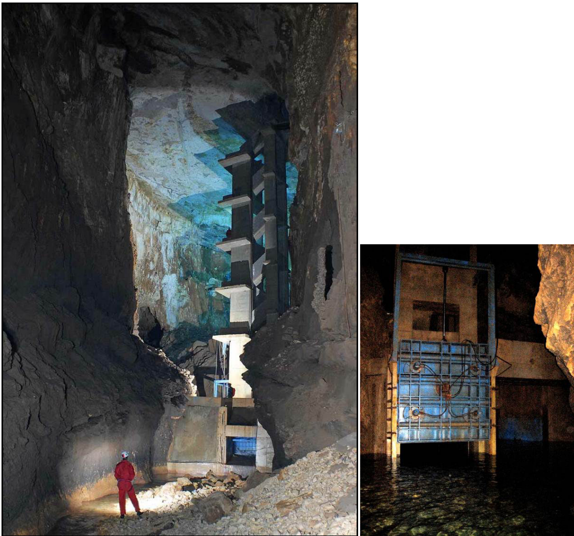
Figure 4.20. La photo de gauche montre la galerie « de la Rivière », prise en aval du barrage construit pour le captage des eaux d'el Kassarat. Nous remarquons à droite les escaliers construits dans le prolongement du forage creusé entre le plancher de la carrière (en surface) et le toit de la galerie. Au premier plan, les gravats constituent le reste d'un chemin aménagé spécialement pour les camions qui amenaient le matériel nécessaire à la construction du barrage et des voies d'accès. Le barrage fait 5 m de hauteur et il est équipé d'une porte d'ouverture (de couleur bleue).
