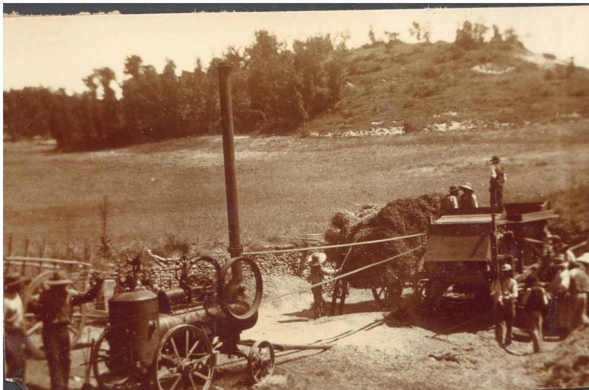
Photo 25 - Locomobile à vapeur et batteuse, 1910
