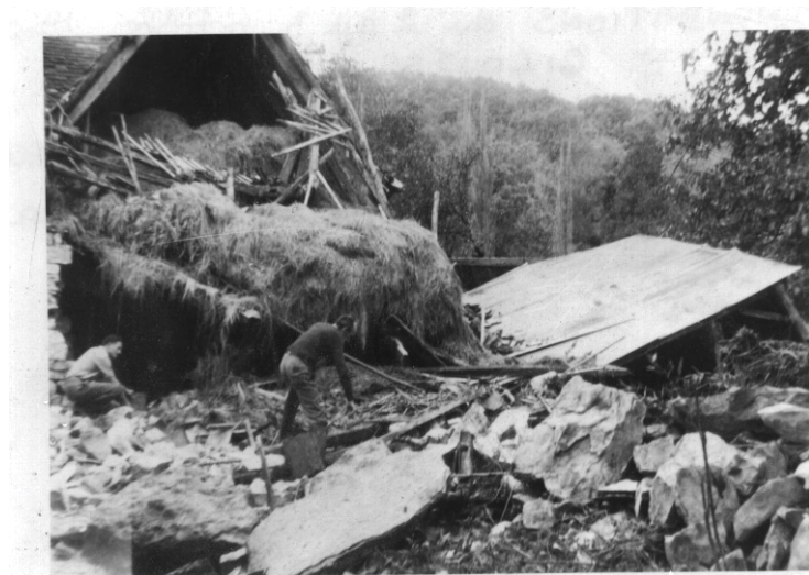
Photo 85 - Un Gigouzacois déblaie sa grange effondrée, 1960
