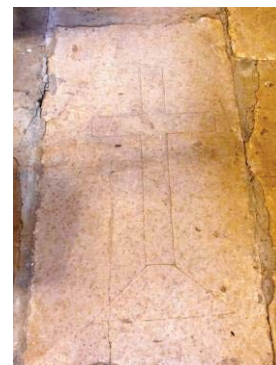
Photo 69 - Croix gravée sur une dalle de la chapelle, 2011 (E. Bour)
