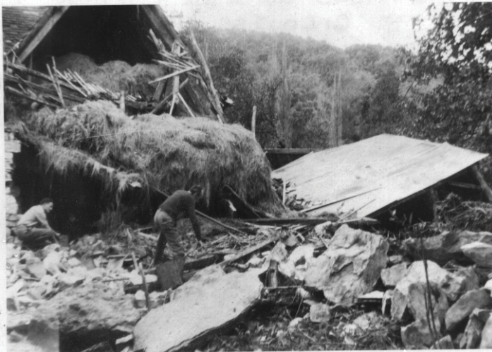
Photo 85 - Un Gigouzacois déblaie sa grange effondrée, 1960
