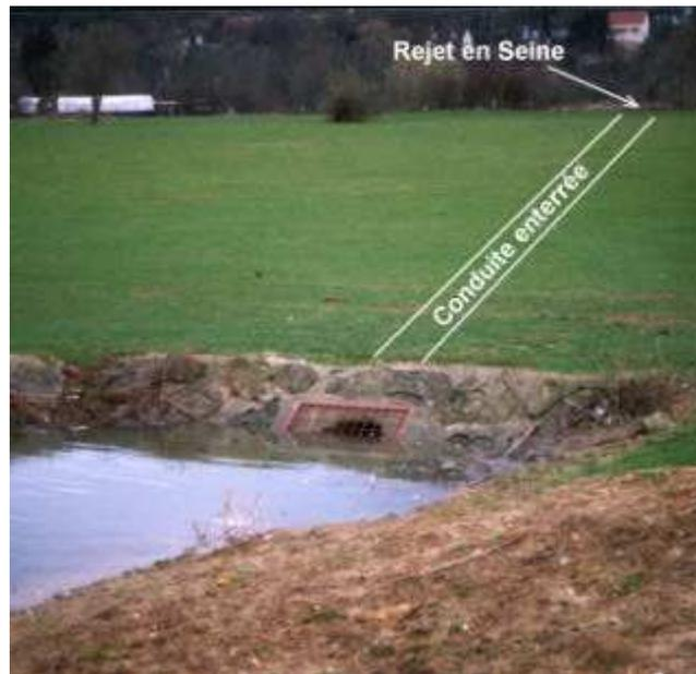
Figure 20 : Surverse, conduite enterrée, rejet en Seine.
