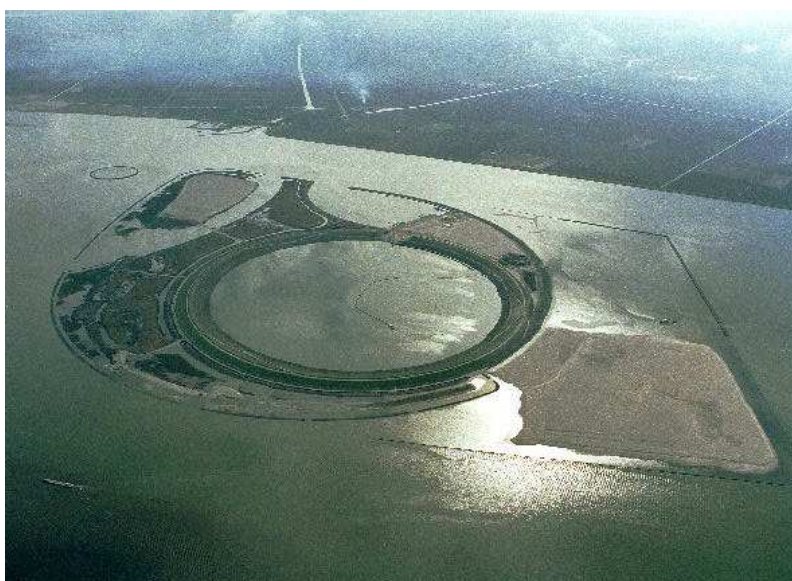
Figure 6 : Vue aérienne du site de stockage confiné de IJsseloog en Hollande (Laboyrie, 2001).
