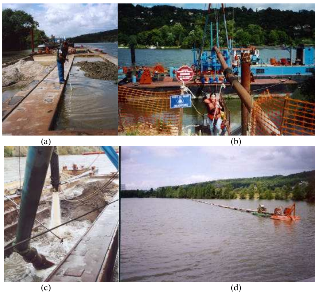
Figure 19 : Procédure de mise en dépôt de matériaux de dragage dans l'étang du Rouillard à Verneuil sur Seine : (a) barge contenant les matériaux de dragage sur la Seine ; (b) bateau refouleur ; (c) remise en suspension des matériaux avec l'eau de Seine pompée sous le bateau refouleur ; (d) conduite qui amène les matériaux dans l'étang après pompage
