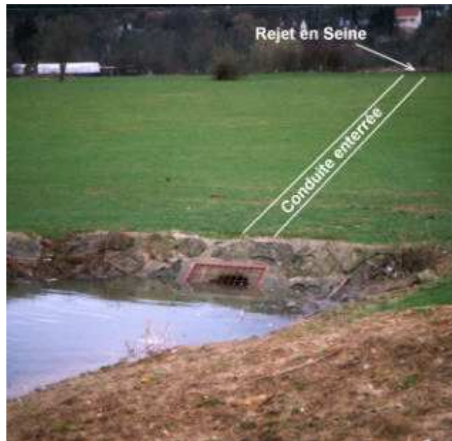
Figure 20 : Surverse, conduite enterrée, rejet en Seine.
