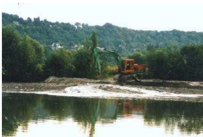
Figure 50 : Construction de la plage sur la partie ouest de l'étang du Rouillard en août 2000.
