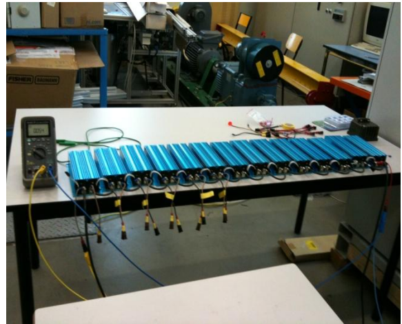
Voltmètre pour la mesure de tension.
