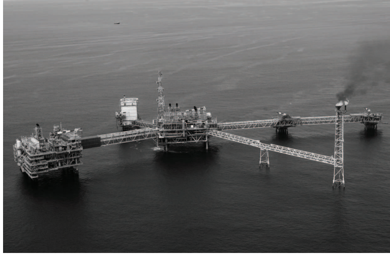
FIGURE 1.7 – Vue aérienne de la plateforme pétrolière de Total située à Amenem, à 35 km de Port Harcourt dans le Delta du Niger. Le gaz naturel extrait avec le pétrole (gaz associé) est brûlé en torchère, à droite sur la photo (Pius Utomi Ekpei/AFP/Getty Images, www.theatlantic.com ).
