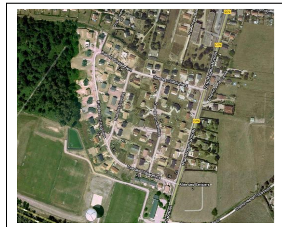
2. La boucle : deux entrées qui établissent une jonction et formant une boucle (image : Pont-de-l'Arche)
