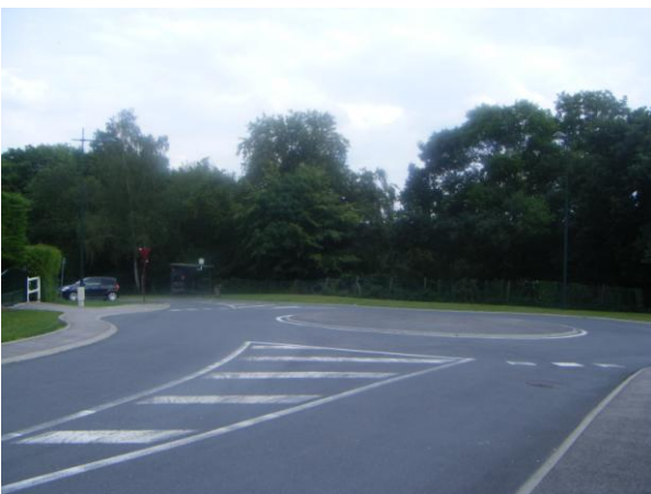
3. Un des nœuds routiers permettant de faire la jonction entre le lotissement et le centre-ville d'Elbeuf. (ici au Sud du lotissement).
