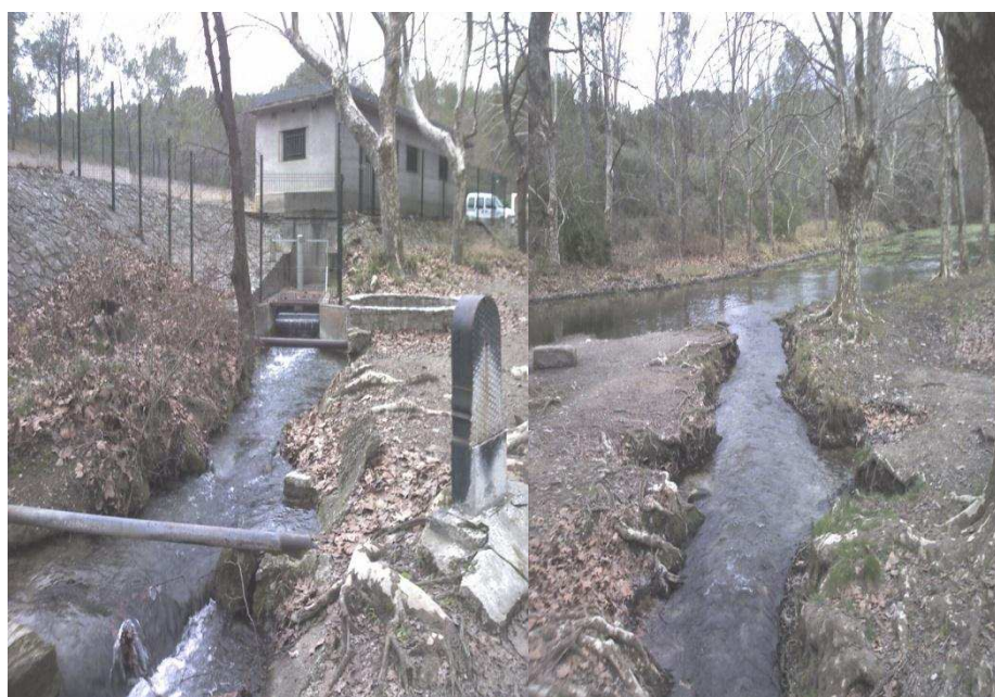
Figure 42 : Déversoir et canal de restitution du débit réservé dans le Lez à 300 m en aval de la source.
