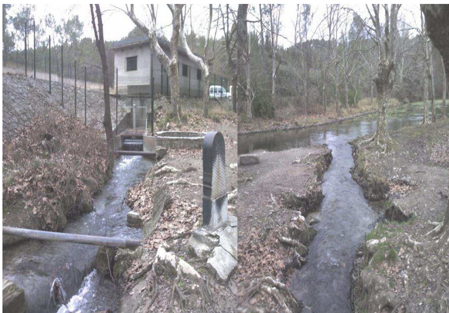
Figure 42 : Déversoir et canal de restitution du débit réservé dans le Lez à 300 m en aval de la source.
