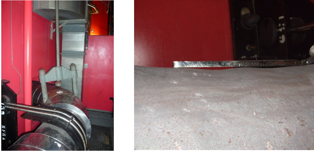
FIGURE 1 – Illustration des dommages engendrés par un coup de béliet sur une tuyauterie du parc de production d'électricité nucléaire d'EDF.
