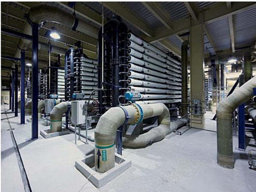
**Figure I-11 : Image d'une installation de filtration d'eau utilisant des modules fibres creuses**
