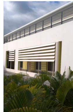
Figure II-28 : Façade ouest (en bas) et est (en haut) des salles d'enseignement de l'IUT
