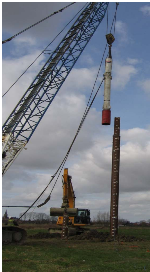
Figure II-12 : Battage d'un pieu métallique tubulaire (Merville)
