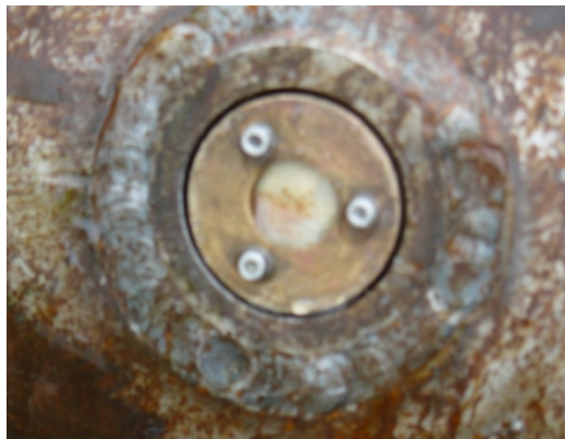
Figure II-20 : Cellule PAC installée sur le pieu de Merville
