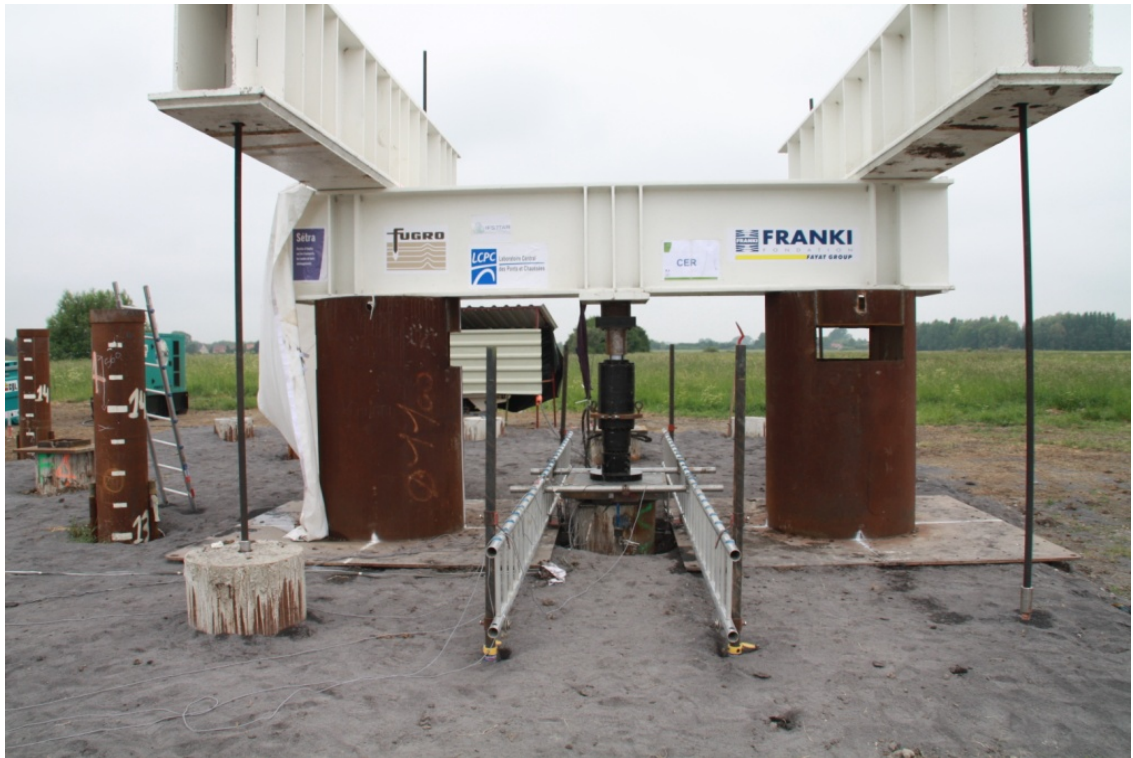
Figure II-26 : Photo du montage d'un essai de chargement en compression
