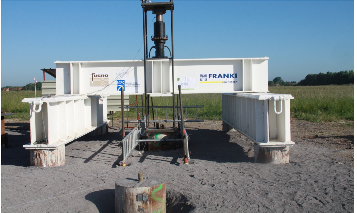
Figure II-27: Photo du montage d'un essai de chargement en traction
