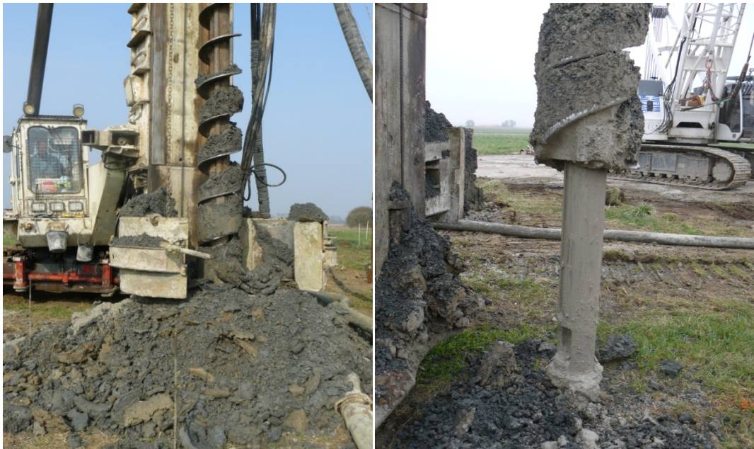
Figure II-13 : La tarière creuse en action et avec tube de bétonnage déployé
