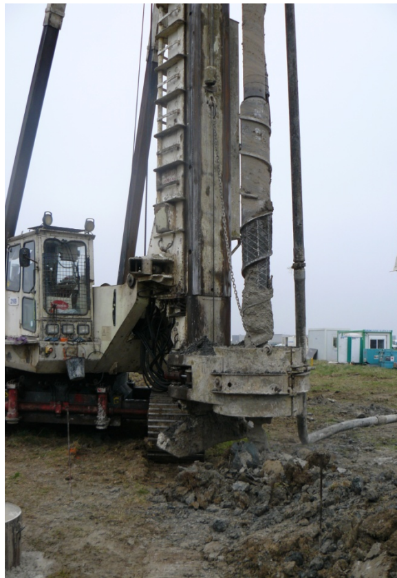
Figure II-14 : Réalisation d'un pieu vissé moulé (Franki Fondation)
