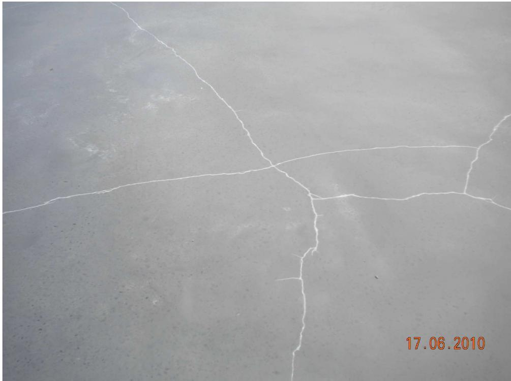
figure 1.4 – Fissuration due aux contraintes résiduelles générées par les constituants
