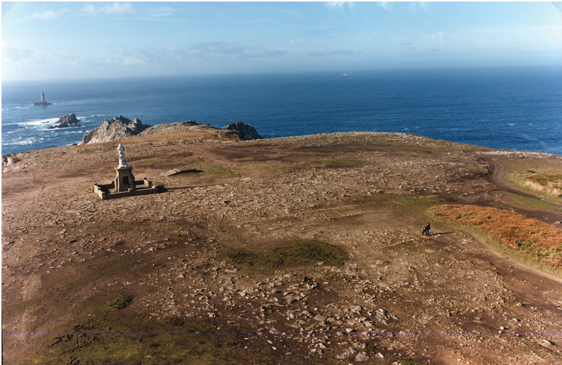
Figure 36 : Photographie de la pointe du Raz 1997 (avant travaux). La situation sur ce cliché est équivalente à celle de 1989, lors du constat établi par le préfet (Source : syndicat mixte de la pointe du Raz).
