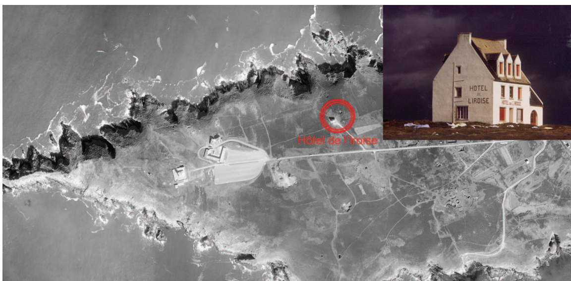
Figure 101 : Localisation et photo de l'hôtel de l'Iroise
