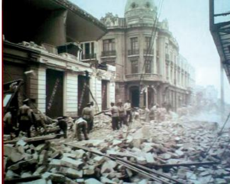
Exemple de destructions lors du séisme crustal d'Ibarra 1868 (Source El Nacional 1872).
