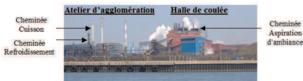
Figure 22 : Photographie de l'usine VMF avec repérage des ateliers et des principales cheminées
