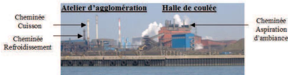
Figure 22 : Photographie de l'usine VMF avec repérage des ateliers et des principales cheminées
