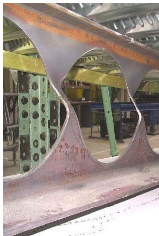
Figure I-19 Double courbure du montant intermédiaire interprétée comme le flambement du montant
