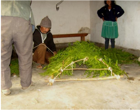
Photo 83 Construction de la petite maison où viendra se reposer l'âme. Qhoari, octobre 2007.
