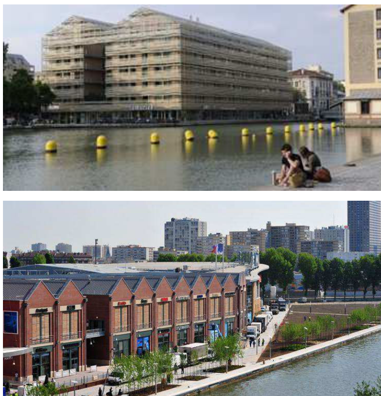
Figure VI-2. Réaménagement des anciens entrepôts sur le bassin de la Villette (Paris, XIX ème ) et à Aubervilliers
