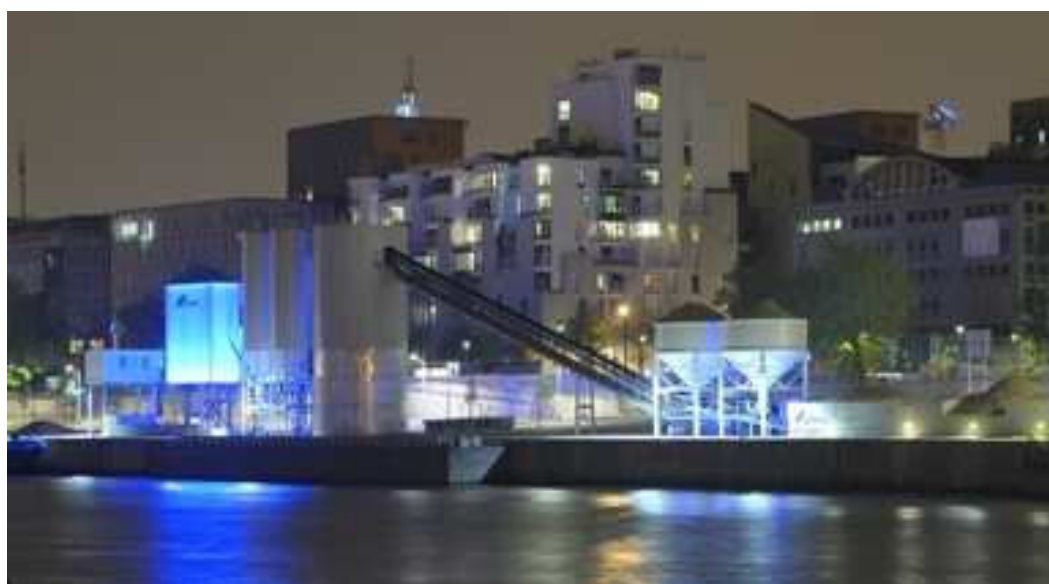
Figure VI-4. Mise en lumière de la centrale à béton, sur le port de Tolbiac
