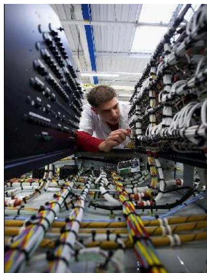
Figure 1-7 Montage des harnais dans un meuble électrique
