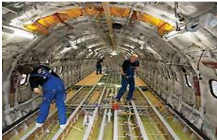
Figure 1-8 Installation de harnais dans un fuselage
