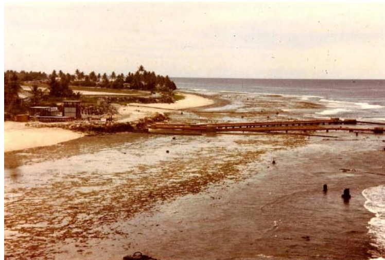
Figure I-17 : L'usine ETM Onshore de Nauru 1980.
