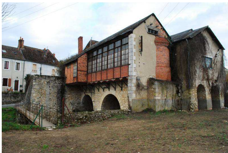
Figure 145 : Point de vue 098 - Menaces de mort sur bâtiments historiques Auteur : Guy Deletang
