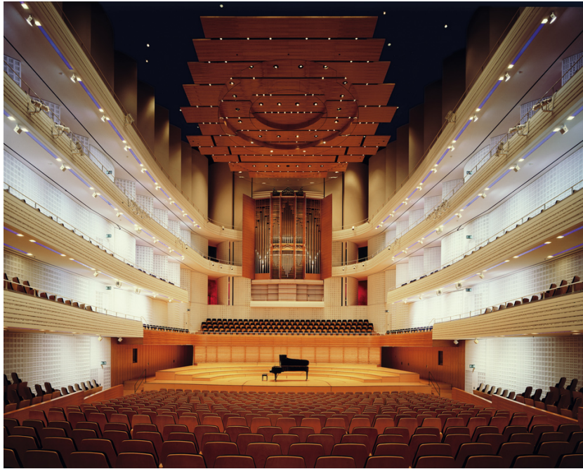
FIGURE 1.3 – Vue de la salle de concert du Kultur- und Kongresszentrum (KKL) à Lucerne, Suisse. Les parois latérales sont composées de portes donnant sur un grand volume vide, la chambre de réverbération. Inauguration : 1998. Acousticien : Artec.
